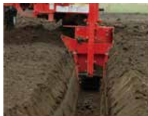
▲明きょ（地表排水）
